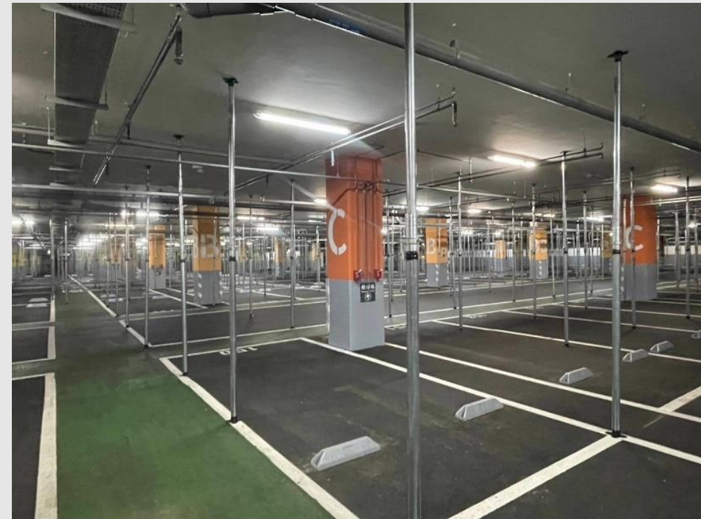
113年9月份地下室頂版全區施作臨時性支撐
