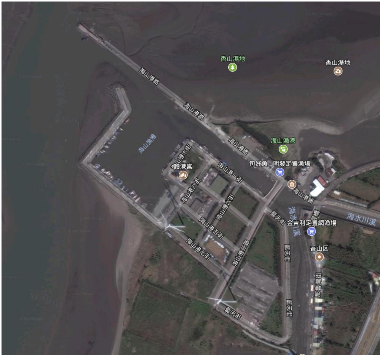
圖3 海山漁港空照圖
